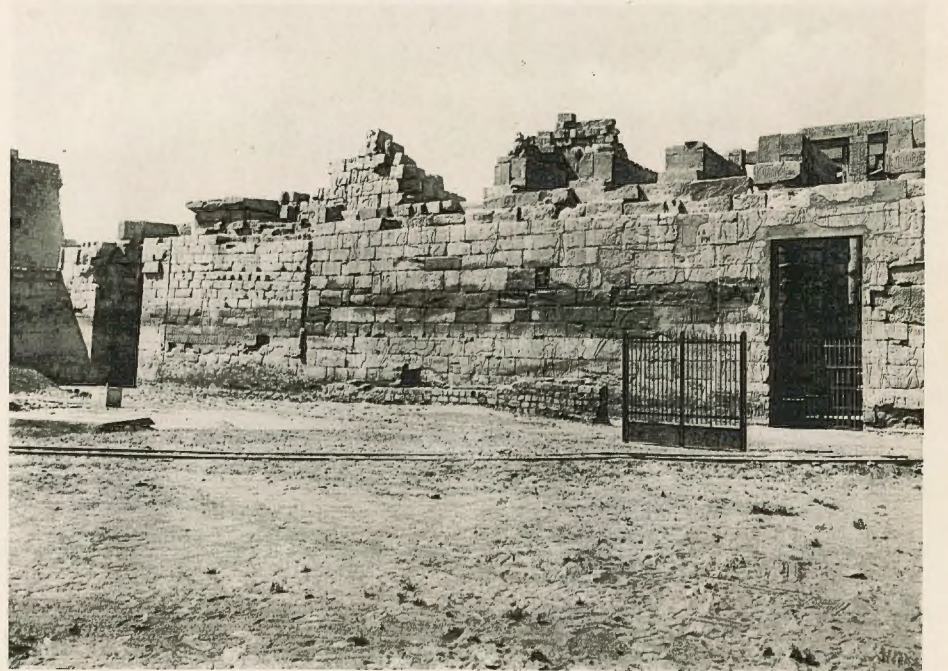
Partie comprise entre la route et le mur Sud de la Salle Hypostyle.
